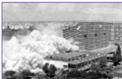
foto 7, Demolición edificio, Francia, 1960
